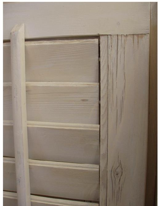
Die **weisse Holzgrundierung** wird mittels Trommeltauchverfahren appliziert. Hier an dieser Stelle empfehlen wir, den **Feinschliff mit nochmaligem Tauchgrundieren** durchzuführen. Dieser zusätzliche Arbeitsgang garantiert die optimale Grundlage für eine lange Haltbarkeit des Farbanstriches.
